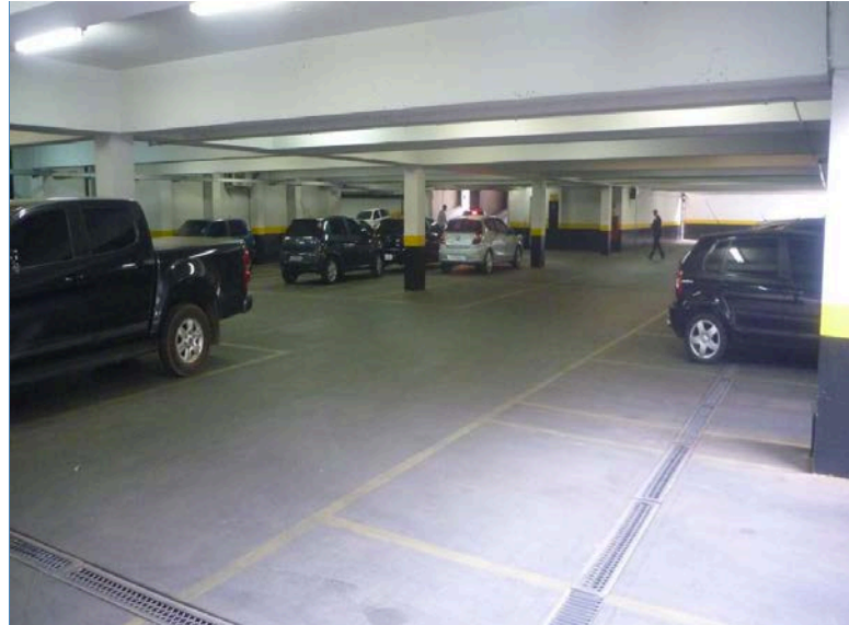
VISTA DO SUBSOLO – ESTACIONAMENTO
