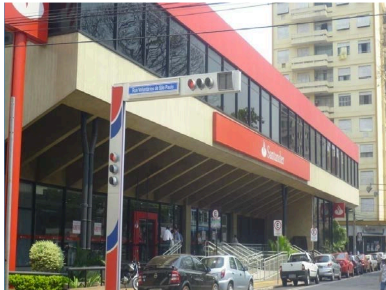
VISTA DA FACHADA DO AVALIANDO
