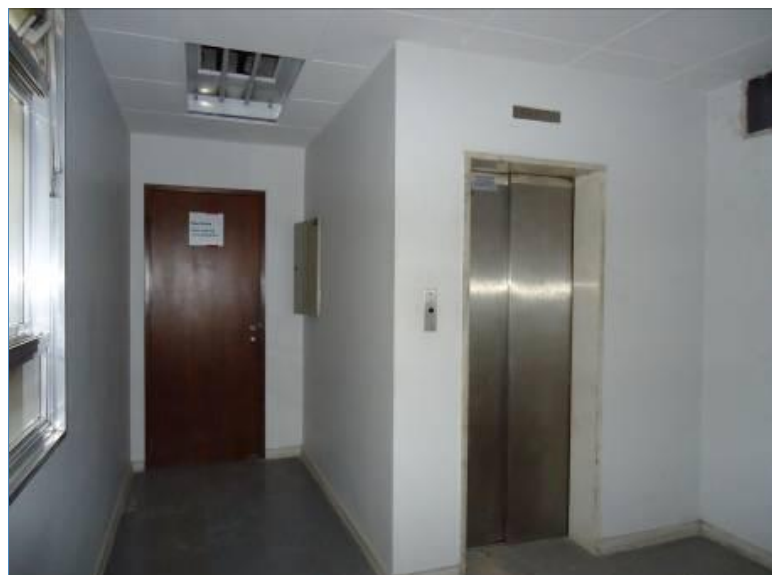
VISTA GERAL INTERNA - 1º PAVIMENTO
