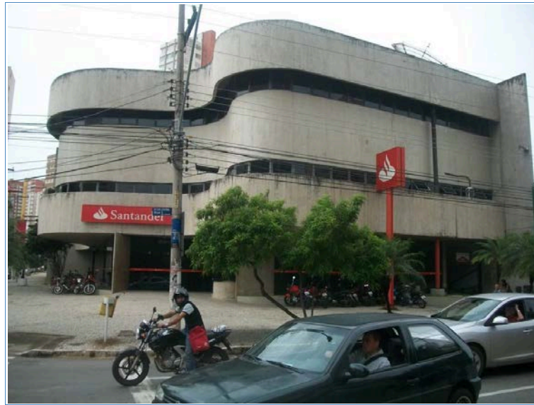
FOTO 01. VISTA DA RUA TRÊS - FACHADA
