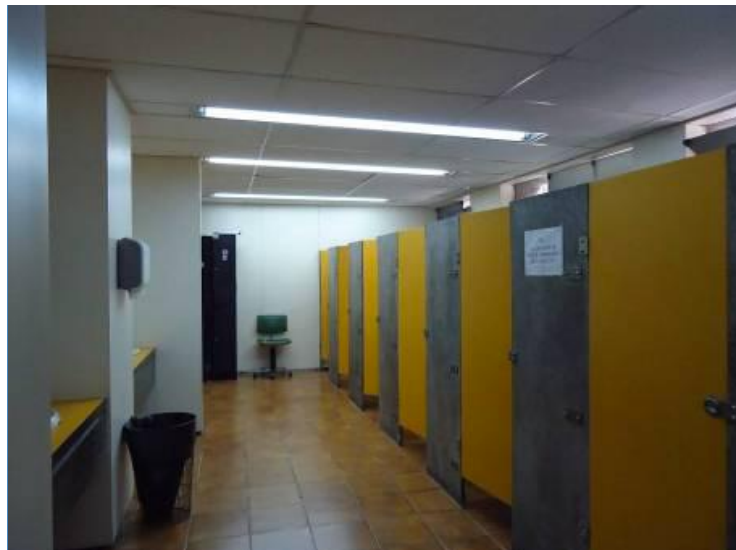
VISTA GERAL DO BANHEIRO – 2º PAVIMENTO
