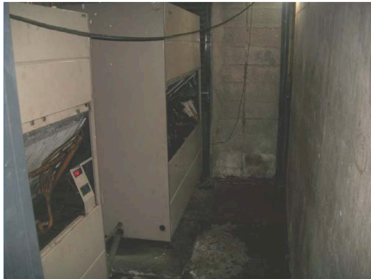
FOTO 28. SUBSOLO- VISTA GERAL DA SALA DE MÁQUINAS
