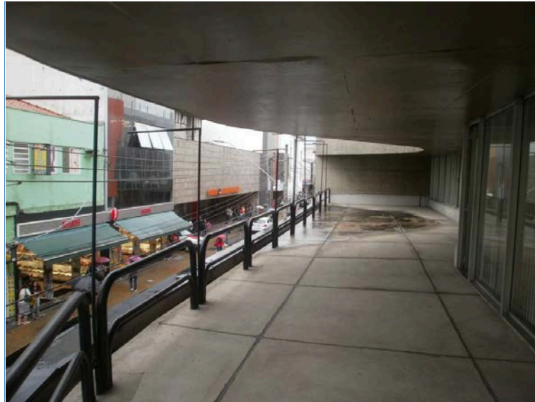
VISTA GERAL INTERNA
