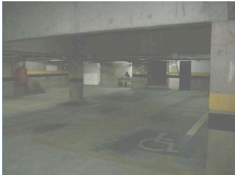
FOTO 26. SUBSOLO- VISTA GERAL DO SUBSOLO
