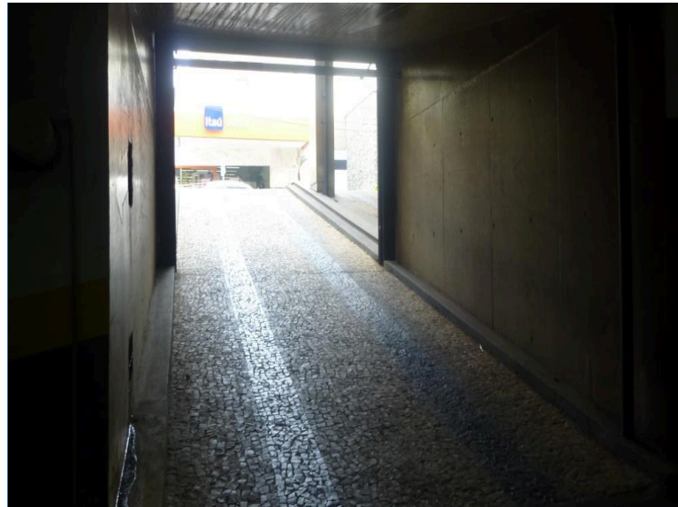
VISTA DO SUBSOLO – ENTRADA DO ESTACIONAMENTO
