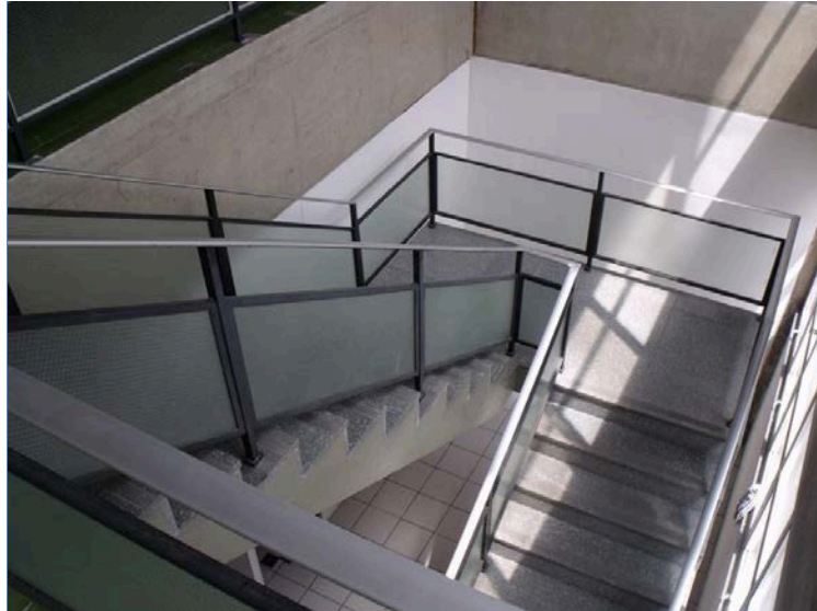
ESCADA DOS FUNDOS ACESSO DO TÉRREO PARA O 2º PAVIMENTO
