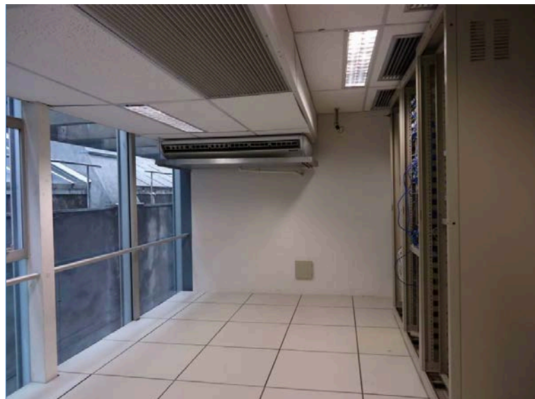
VISTA GERAL INTERNA - 2º PAVIMENTO
