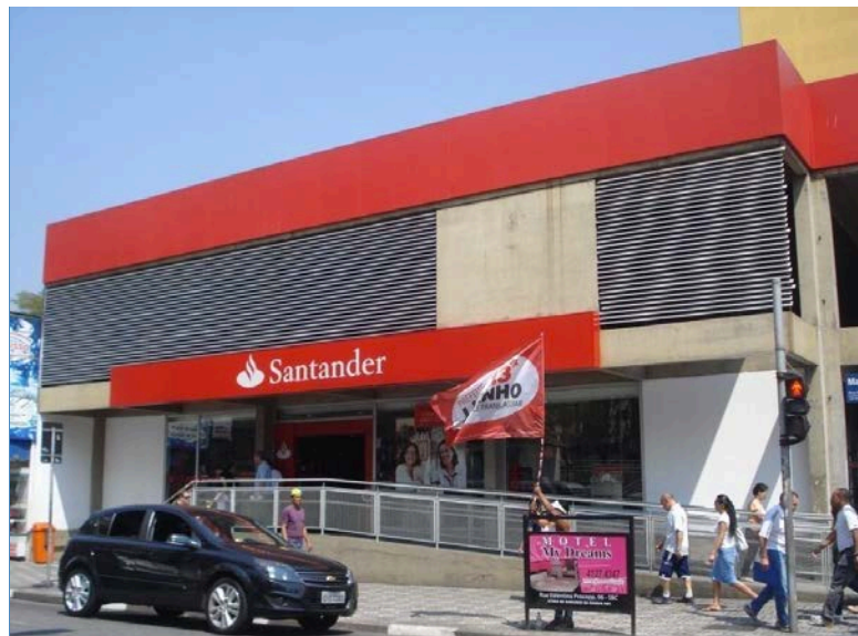
ASPECTOS DA FACHADA
