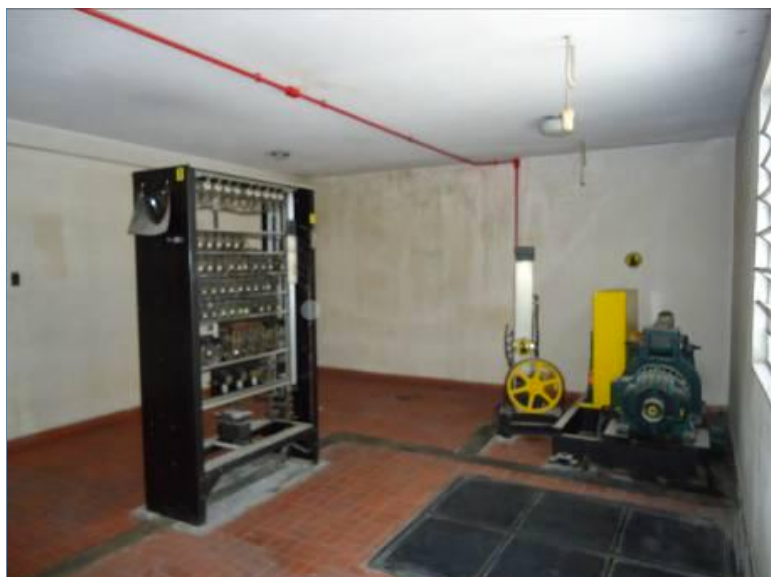
VISTA GERAL DA CASA DE MÁQUINAS - COBERTURA
