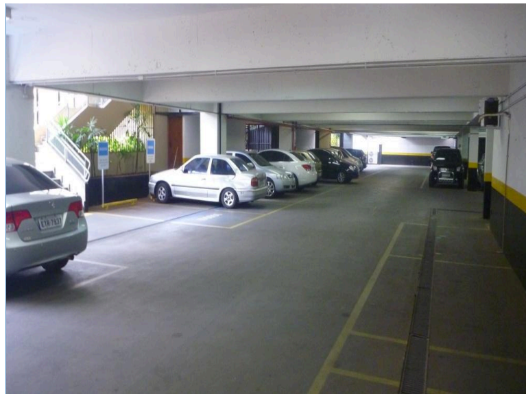
VISTA DO SUBSOLO – ESTACIONAMENTO
