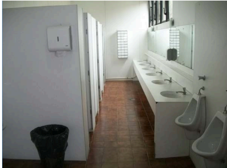
FOTO 19 1º PAVIMENTO SUPERIOR – VISTA GERAL DO SANITÁRIO MASCULINO
