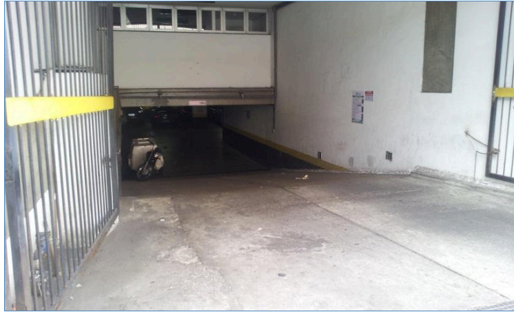
RAMPA DE ACESSO PARA O SUBSOLO - GARAGEM
