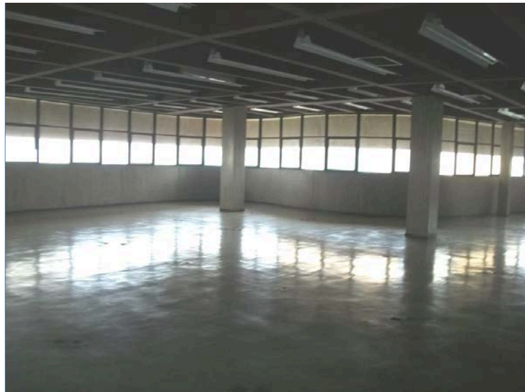
FOTO 22. 2º PAVIMENTO SUPERIOR – VISTA GERAL DO 2º PAVIMENTO SUPERIOR
