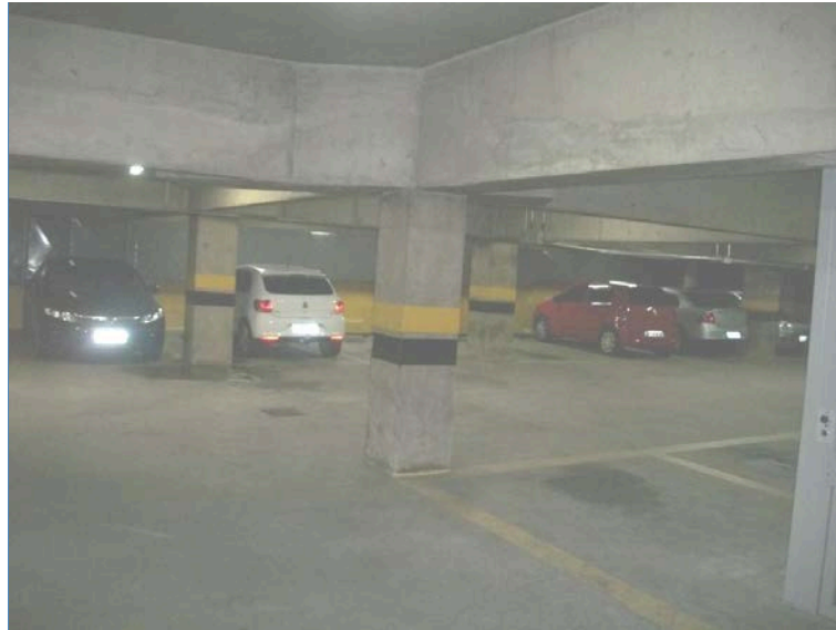
FOTO 25. SUBSOLO- VISTA GERAL DO SUBSOLO
