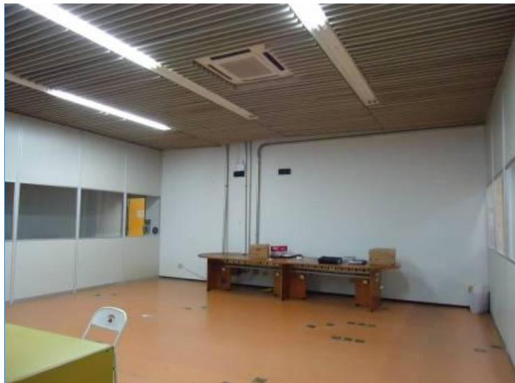
VISTA GERAL DA SALA - 2º PAVIMENTO
