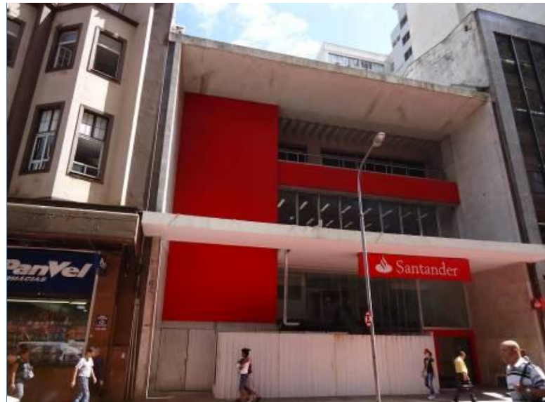
VISTA GERAL DA FACHADA
