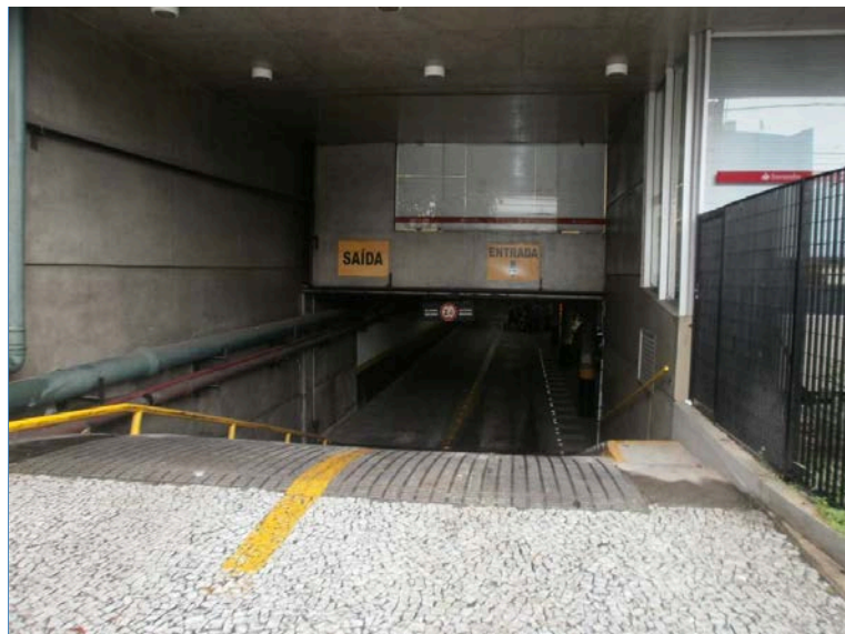
VISTA GERAL DO ACESSO AO ESTACIONAMENTO
