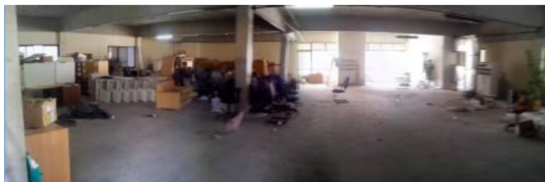
PANORÂMICA - 2º PAVIMENTO (EM REFORMA)
