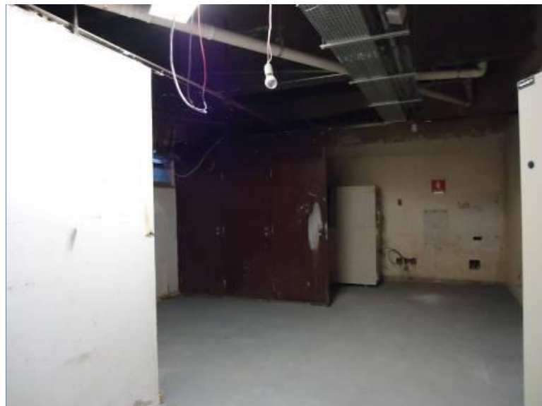
VISTA GERAL INTERNA – SUBSOLO
