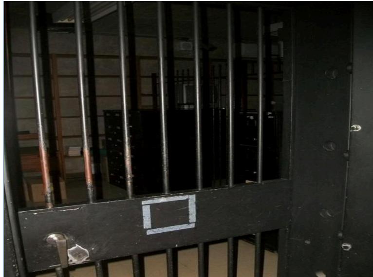
FOTO 21. 1º PAVIMENTO SUPERIOR – VISTA GERAL DO ACESSO AO COFRE
