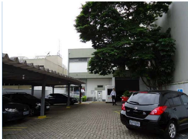
VISTA GERAL DO ESTACIONAMENTO – PAVIMENTO TÉRREO
