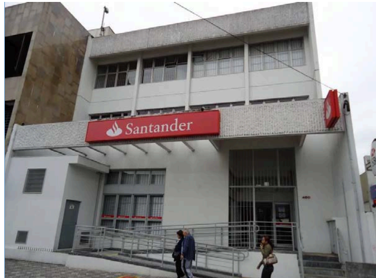
VISTA GERAL DA FACHADA
