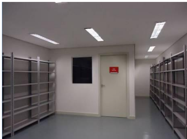
VISTA GERAL INTERNA – SUBSOLO
