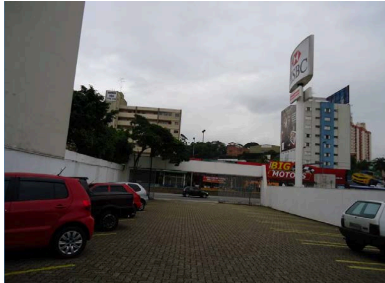
VISTA GERAL DO ESTACIONAMENTO – PAVIMENTO TÉRREO
