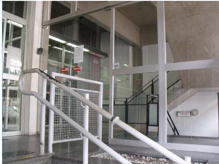
ENTRADA PRINCIPAL - ESCADA DE ACESSO SUBSOLO E 1º PAVIMENTO
