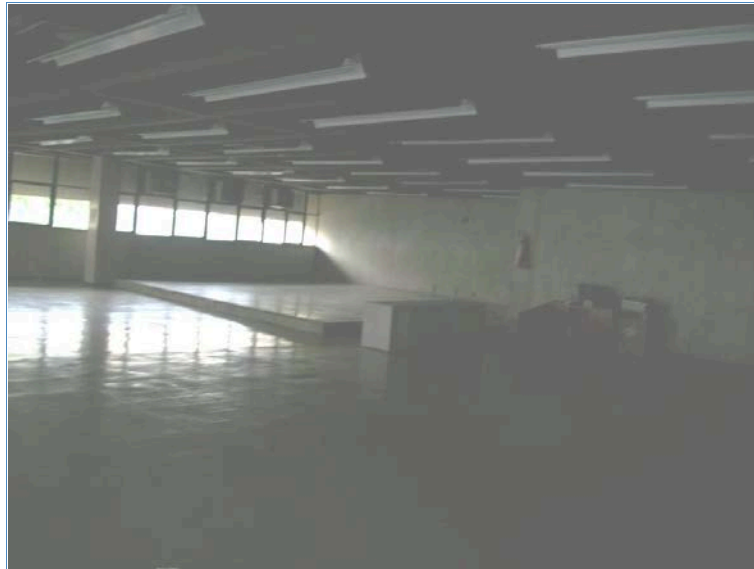
FOTO 23. 2º PAVIMENTO SUPERIOR – VISTA GERAL DO 2º PAVIMENTO SUPERIOR
