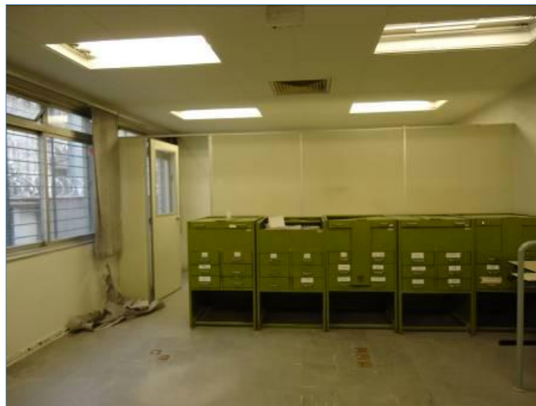
VISTA GERAL INTERNA - 1º PAVIMENTO
