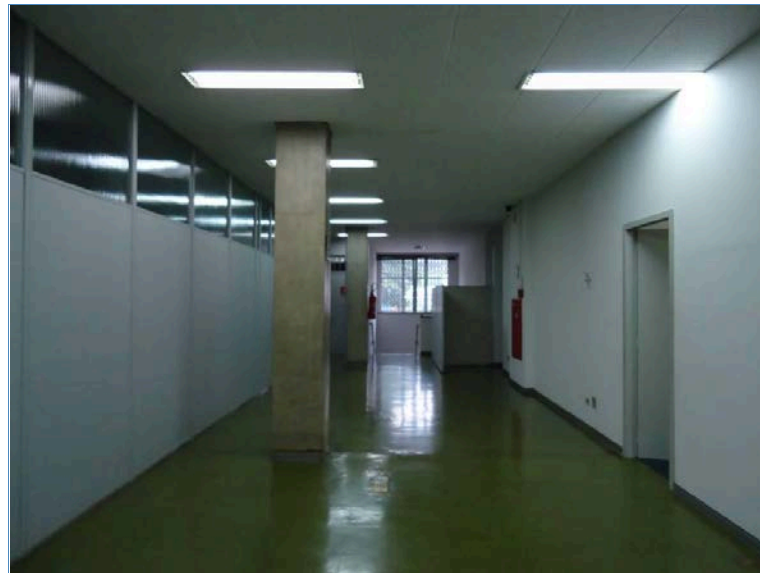
VISTA GERAL INTERNA - 1º PAVIMENTO
