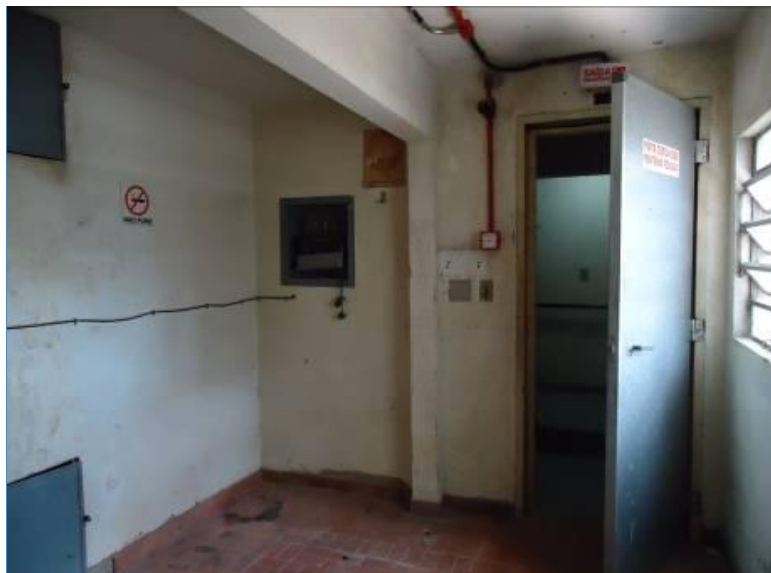
VISTA GERAL INTERNA - COBERTURA
