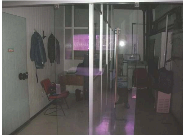
FOTO 15. 1º PAVIMENTO SUPERIOR – VISTA GERAL DA SALA TÉCNICA
