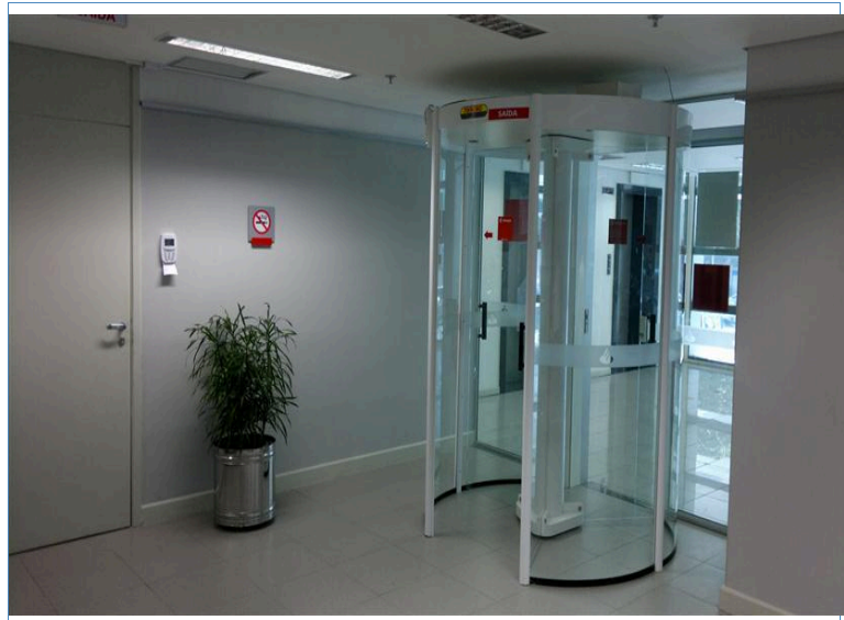
ACESSO A SOBRELOJA PELO PRÉDIO
