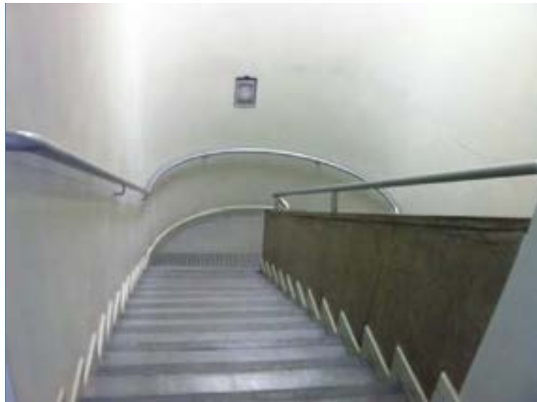
VISTA DO 1º PAVIMENTO – ESCADA DE ACESSO
