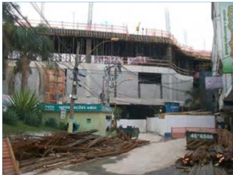
RUA SÃO PEDRO DE ALCÂNTARA – OBRAS DO SHOPPING
