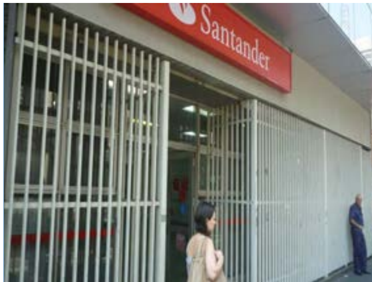
VISTA DA FACHADA DO AVALIANDO
