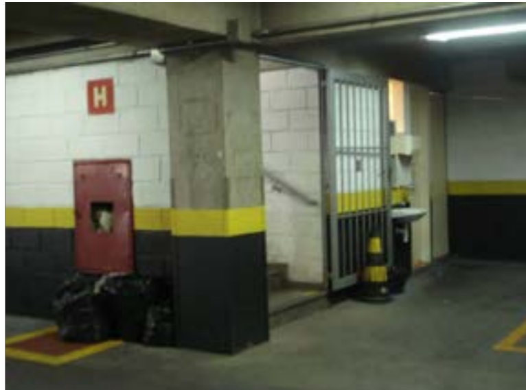
ASPECTOS DO ACESSO DE PEDESTRE AO ESTACIONAMENTO
