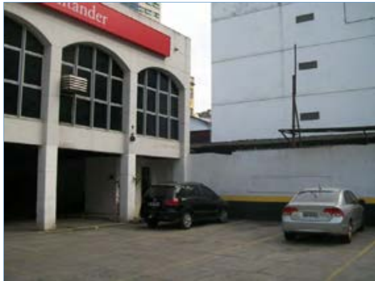
FACHADA FUNDOS - ESTACIONAMENTO
