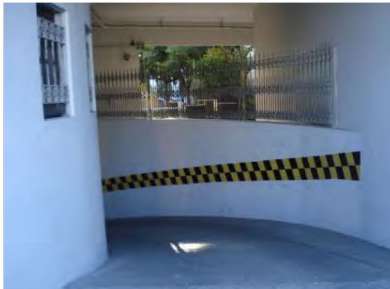
ACESSO AO SUBSOLO (ESTACIONAMENTO)
