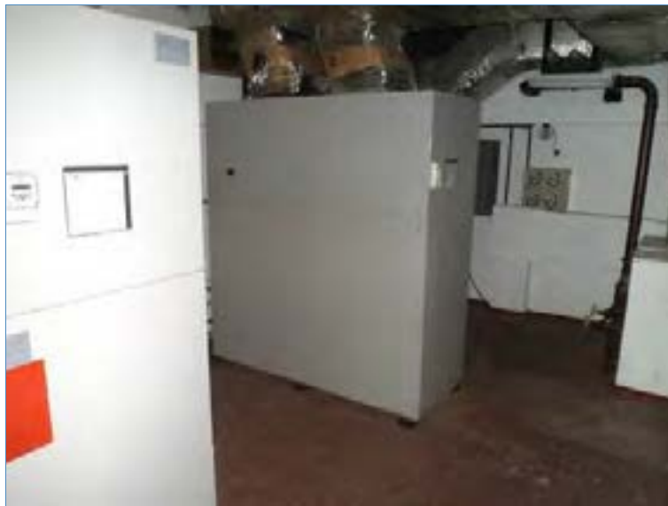
VISTA INTERNA DA CASA DE MÁQUINAS DO AR CONDICIONADO CENTRAL DO SUBSOLO
