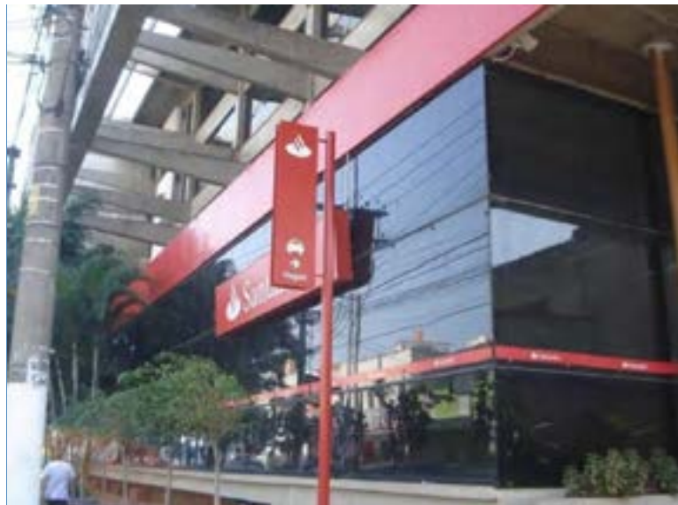
ASPECTOS DA FACHADA DA AGÊNCIA
