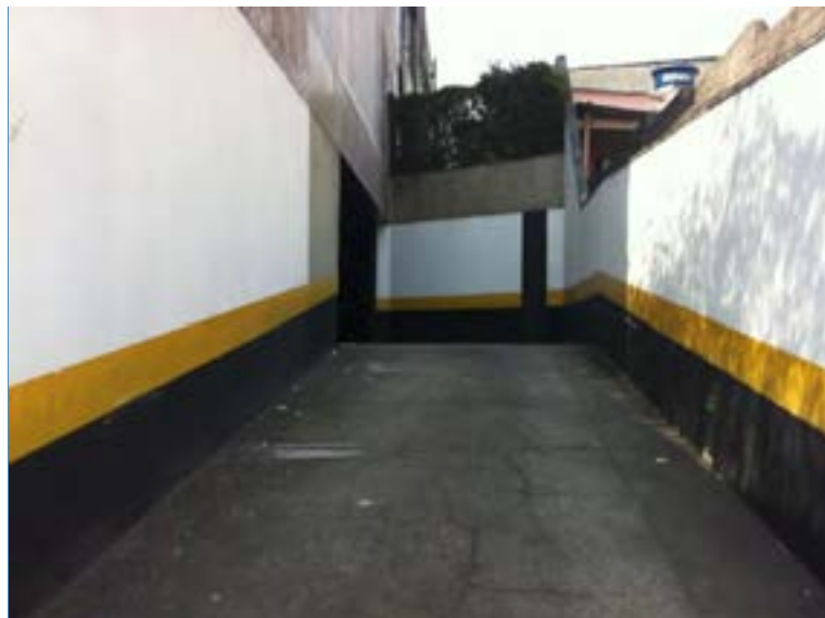
VISTA DO PAVIMENTO SUBSOLO – SAÍDA DA PELA AV. MATEO BEI
