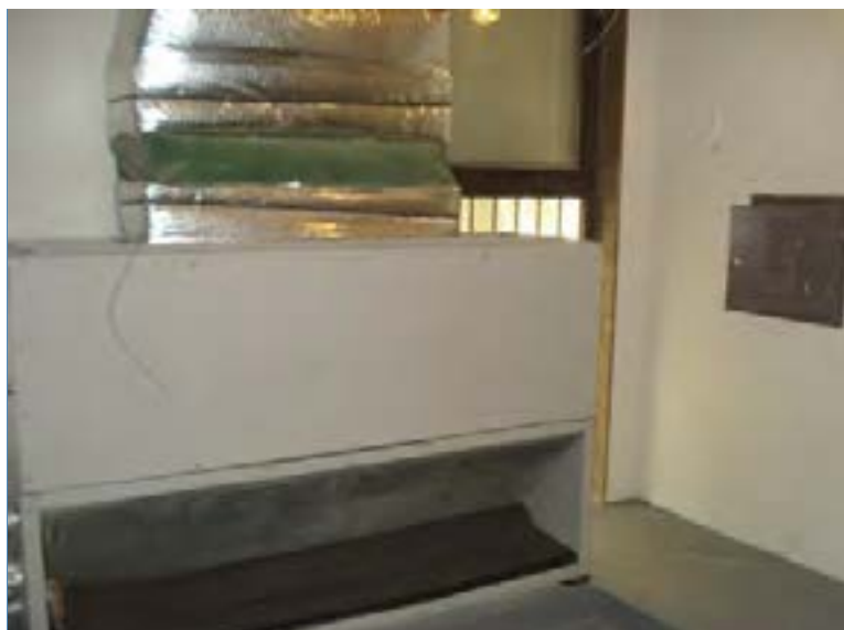
SALA DE AR CONDICIONADO
