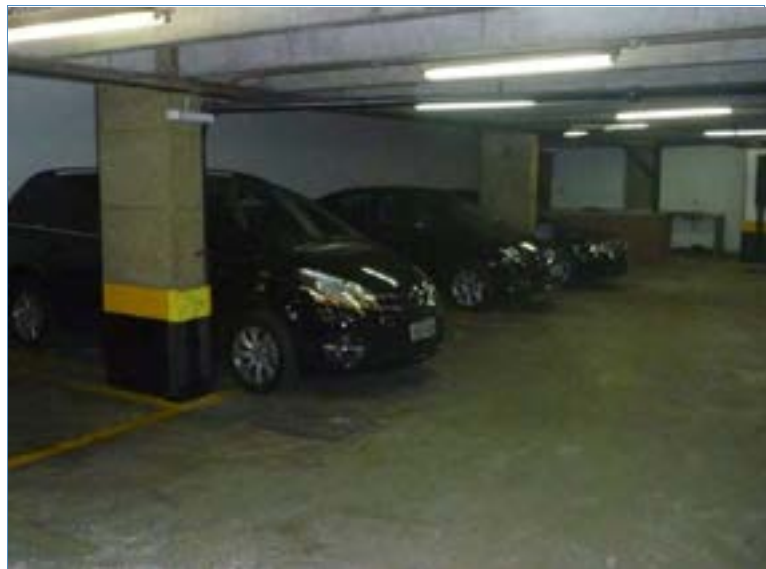
VISTA GERAL INTERNA – SUBSOLO
