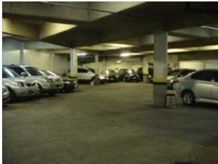
ASPECTOS DO ESTACIONAMENTO
