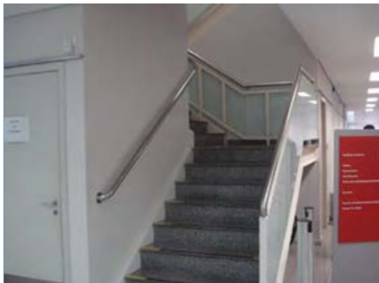
ASPECTOS DA ESCADA DE ACESSO AO 1º PAVIMENTO
