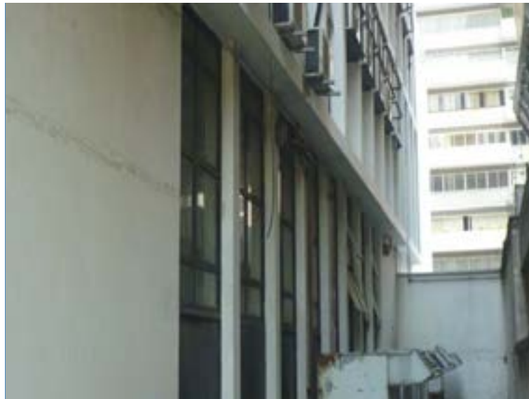
VISTA DA FACHADA DO FUNDO DO AVALIANDO
