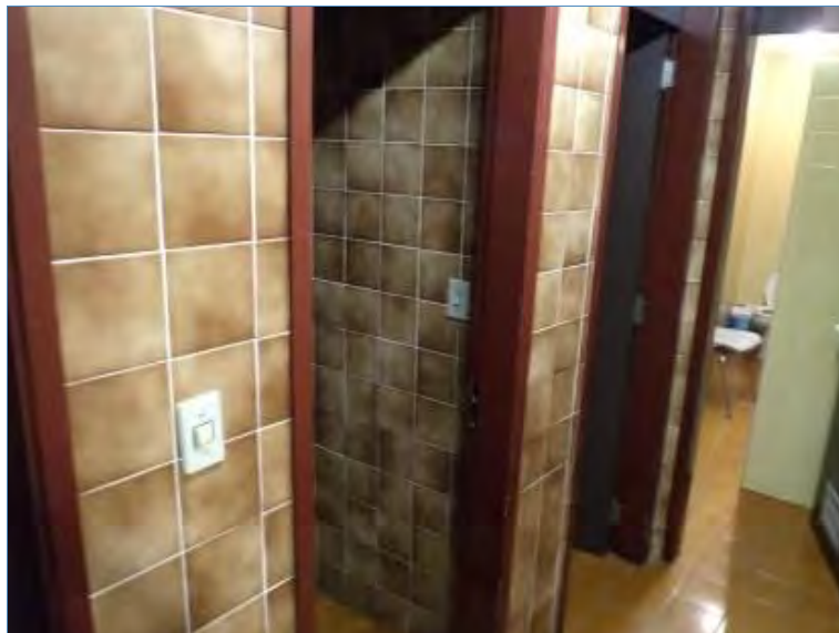
VISTA INTERNA SANITÁRIO DO 1° MEZANINO
