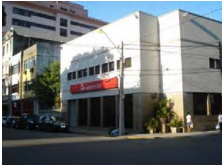
VISTA DA FACHADA (RUA IMPERADOR PEDRO SEGUNDO)
