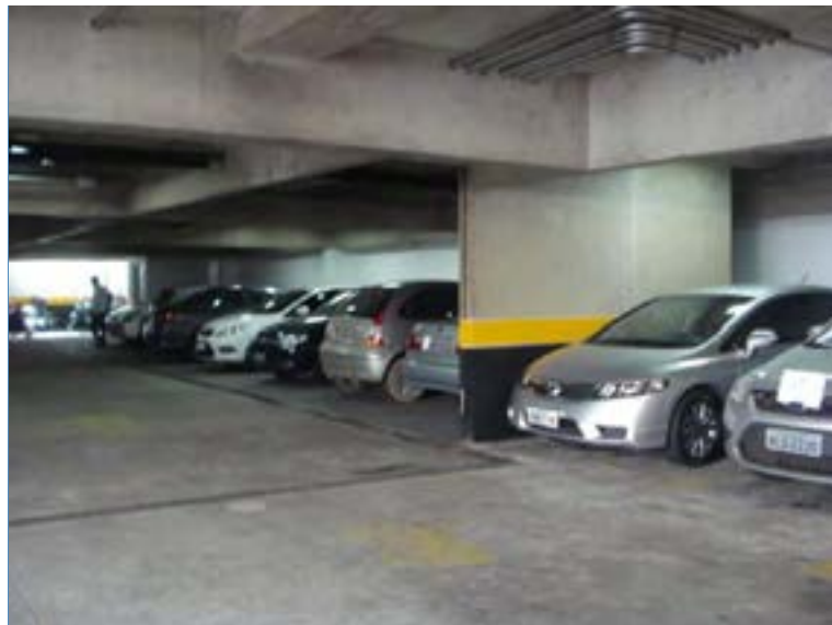
ASPECTOS DO ESTACIONAMENTO
