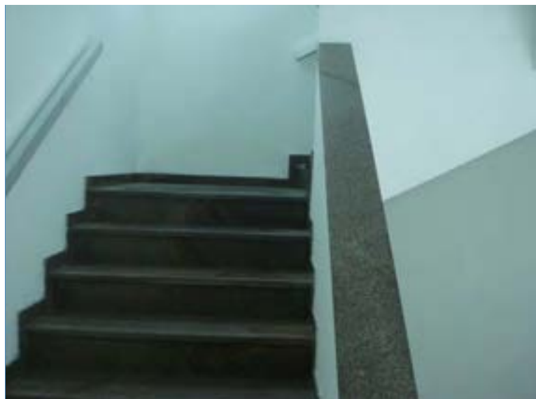
ASPECTO DA ESCADA DE EMERGÊNCIA (4° PAVIMENTO)
