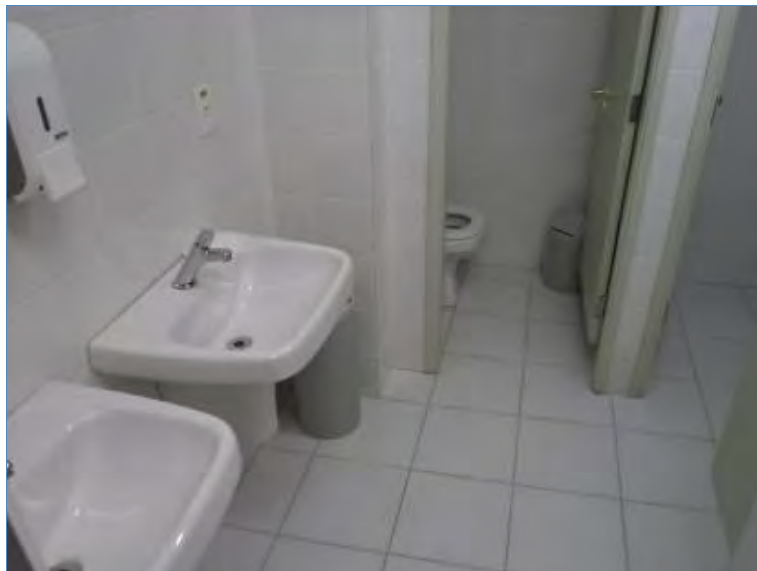
VISTA INTERNA DO SANITÁRIO DO PAVIMENTO SUPERIOR
