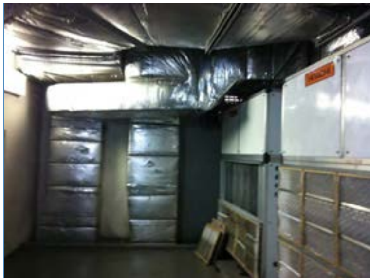
VISTA DO 1º PAVIMENTO – AR CONDICIONADO
