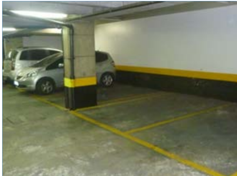
VISTA GERAL INTERNA – SUBSOLO
