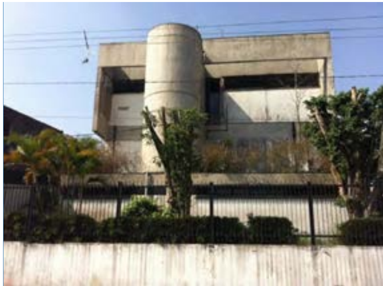
VISTA DA FACHADA DO FUNDO – RUA DR. JOSÉ CIOFFI
