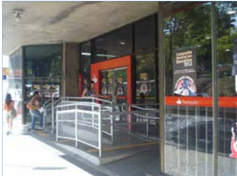
ASPECTOS DA ACESSIBILIDADE NA ENTRADA DA AGÊNCIA
