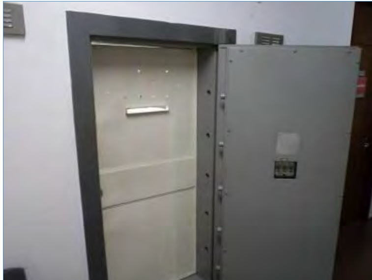
VISTA INTERNA DO ACESSO AO COFRE NO SUBSOLO
