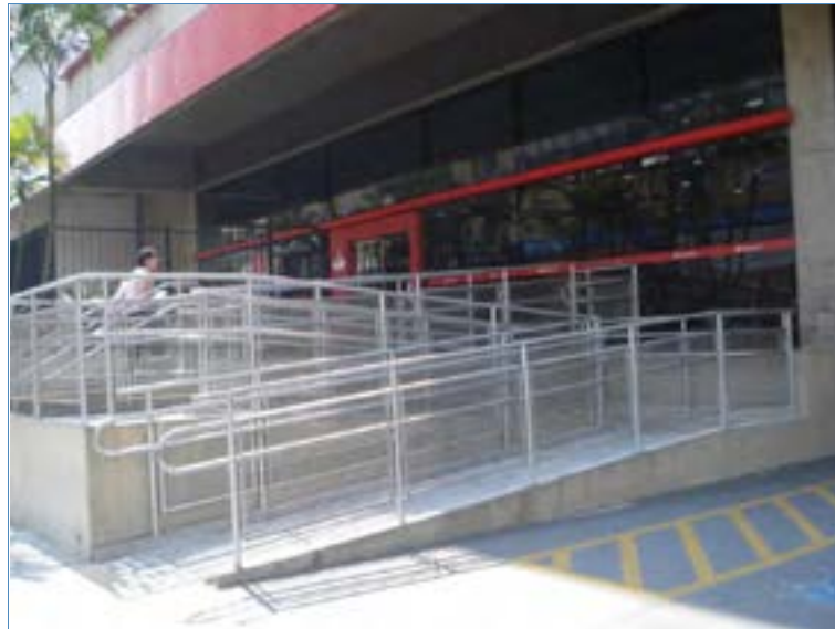
ASPECTOS DA ACESSIBILIDADE NA ENTRADA DA AGÊNCIA
