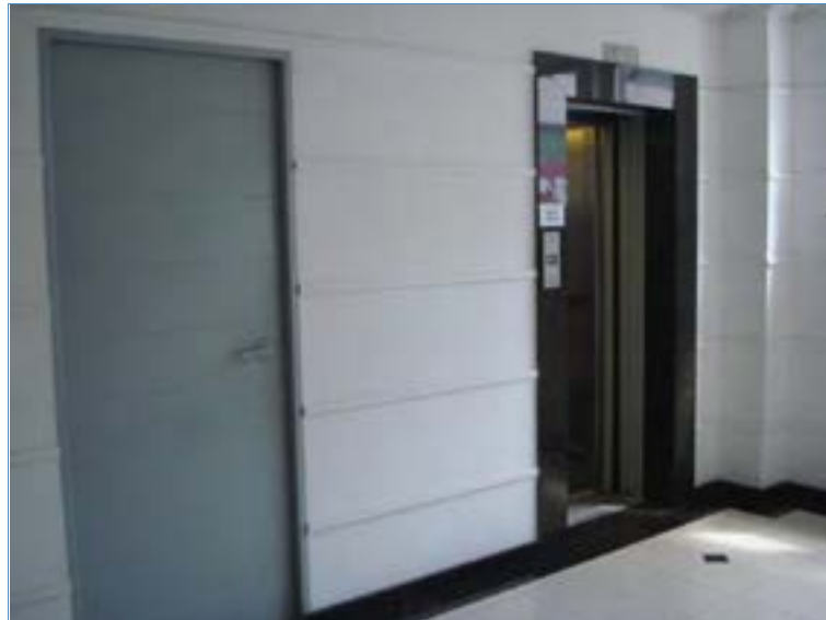
ASPECTO HALL DE ELEVADOR E ESCADA DE EMERGÊNCIA (3° PAVIMENTO)
