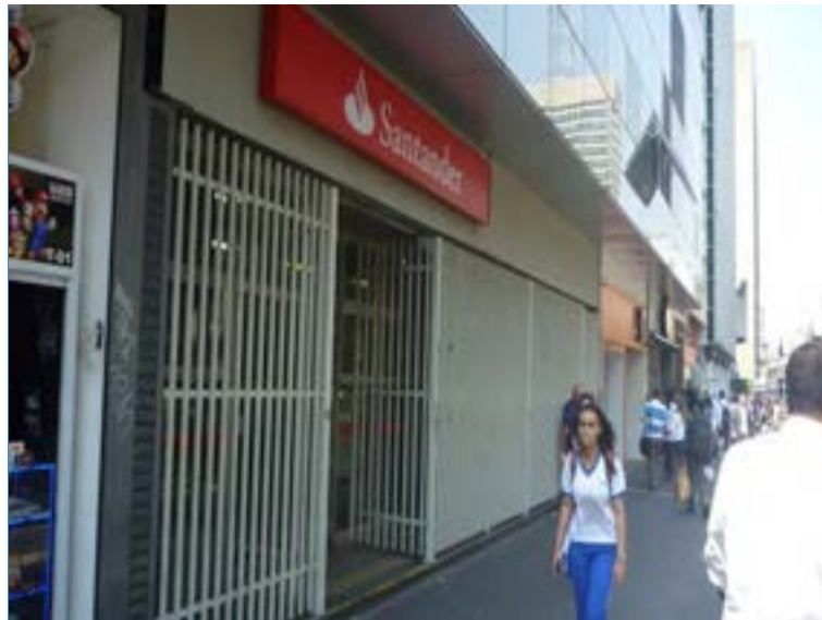
VISTA DA FACHADA DO AVALIANDO
