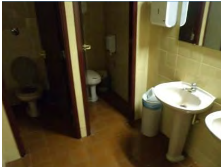
VISTA INTERNA DO SANITÁRIO DO SUBSOLO
