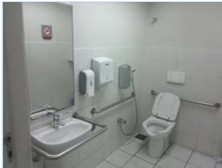
BANHEIRO ADAPTADO PNE
