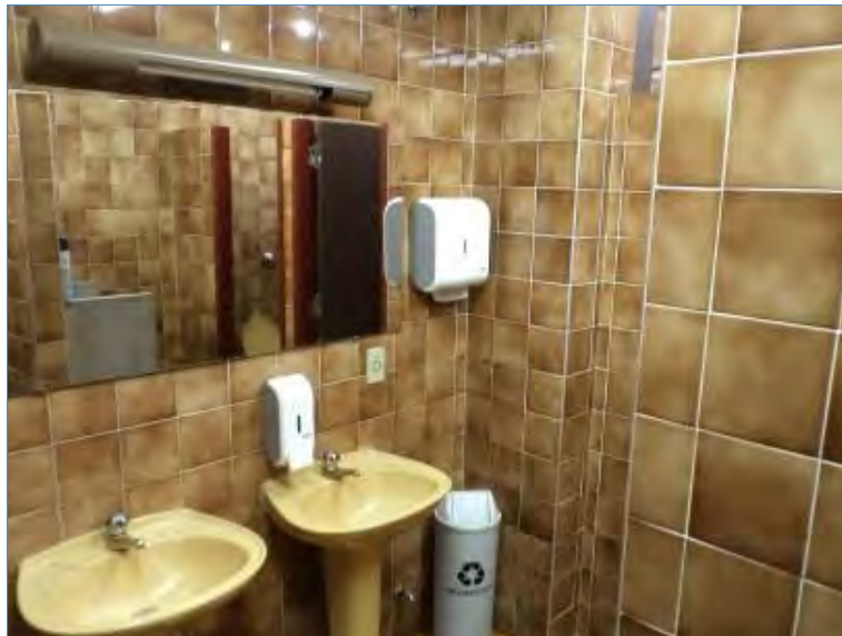
VISTA INTERNA DO SANITÁRIO DO 2° MEZANINO
