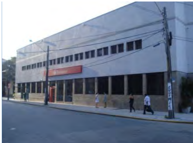
VISTA DA FACHADA (RUA SIQUEIRA DE CAMPOS)
