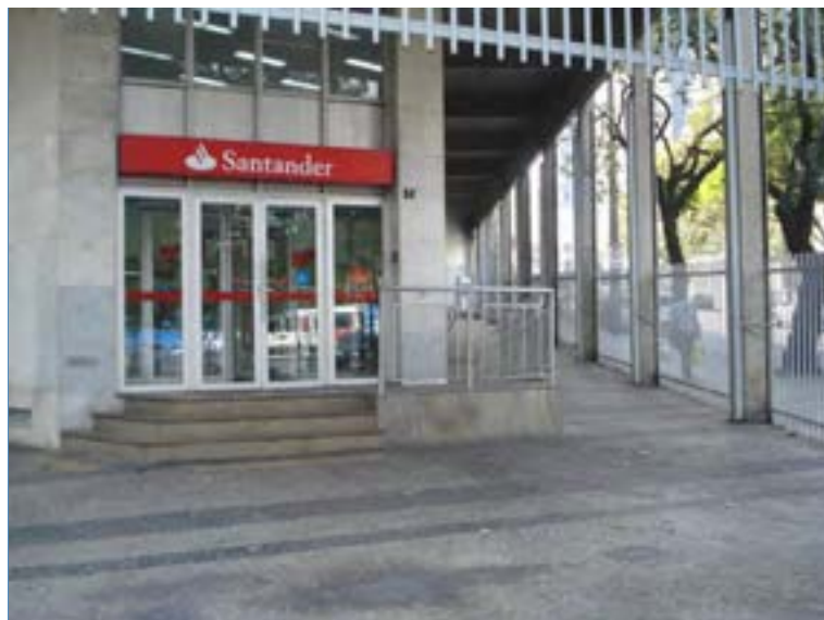
ASPECTOS DA FACHADA DA AGÊNCIA
