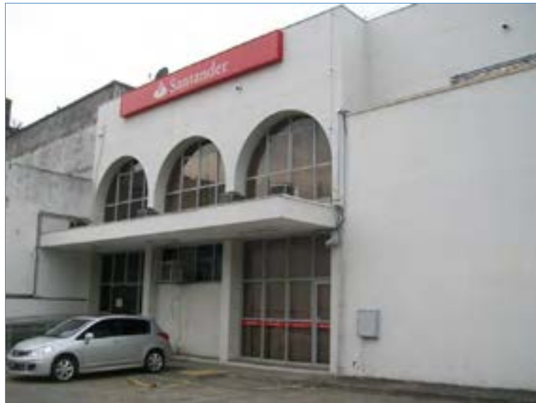
FACHADA FUNDOS - ESTACIONAMENTO
