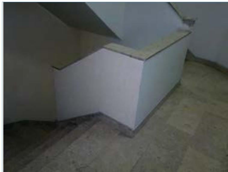
ACESSO A SOBRELOJA
