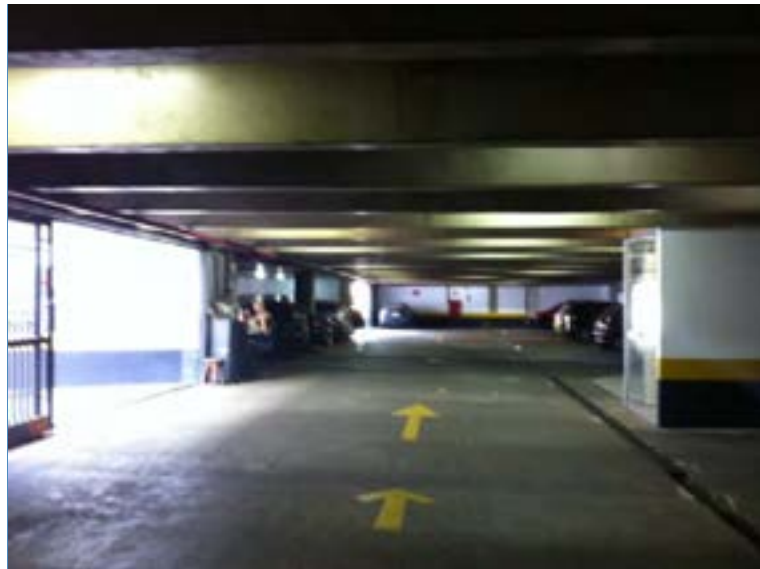
VISTA DO PAVIMENTO SUBSOLO – GARAGEM
