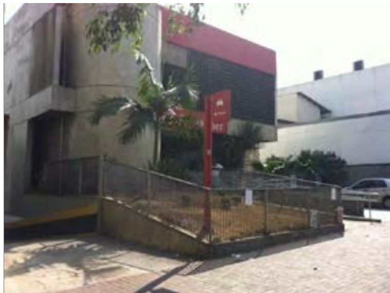
VISTA DA FACHADA DA FRENTE – AVENIDA MATEO BEI
