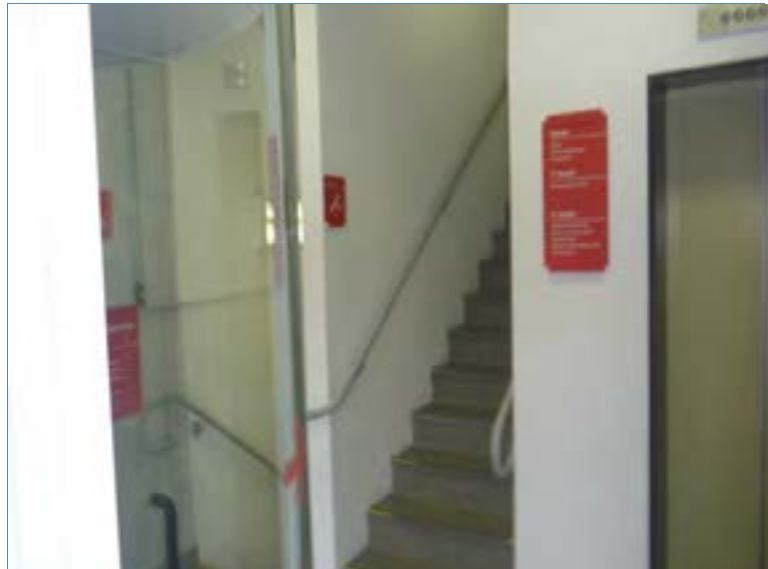
ASPECTO GERAL DA CIRCULAÇÃO (ACESSO AO 1º PAVIMENTO)
