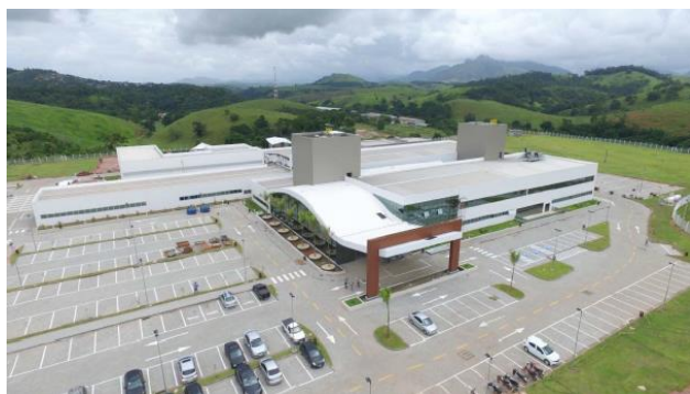
Finalização da demarcação das vagas de garagem e do paisagismo externo
