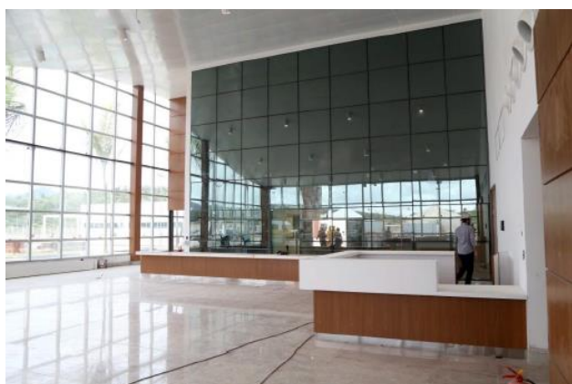
Montagem dos mobiliários da recepção principal
