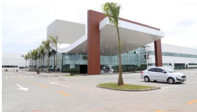
Finalização da instalação do ACM e do sistema de pele de vidro da fachada
