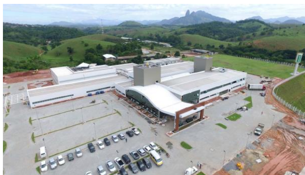
Execução do fechamento das torres e paisagismo externo
