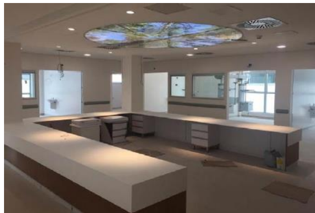
Montagem do mobiliário e do black light na UTI
