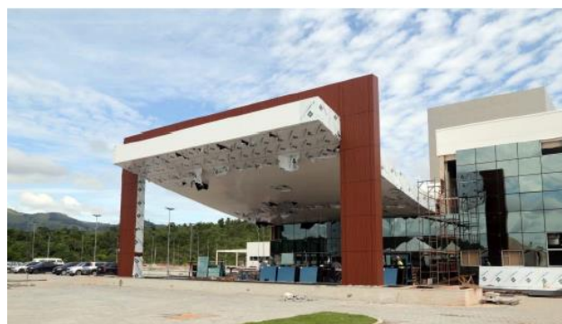
Finalização da instalação do ACM do pórtico da entrada principal
