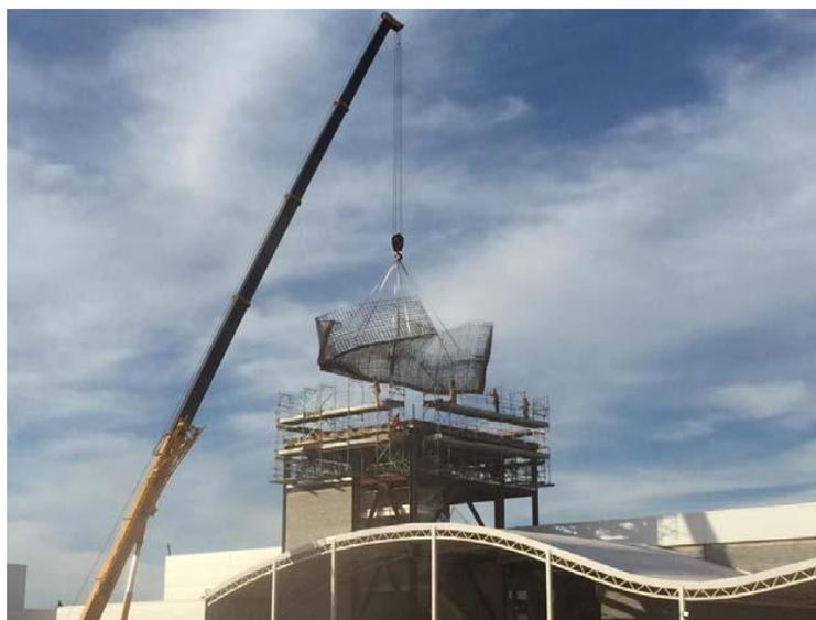
Içamento da armação dos reservatórios superiores nas torres
