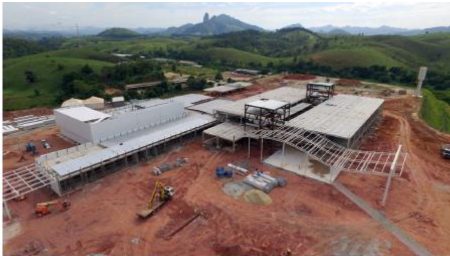
Foto área da obra – Montagem da estrutura das telhas
