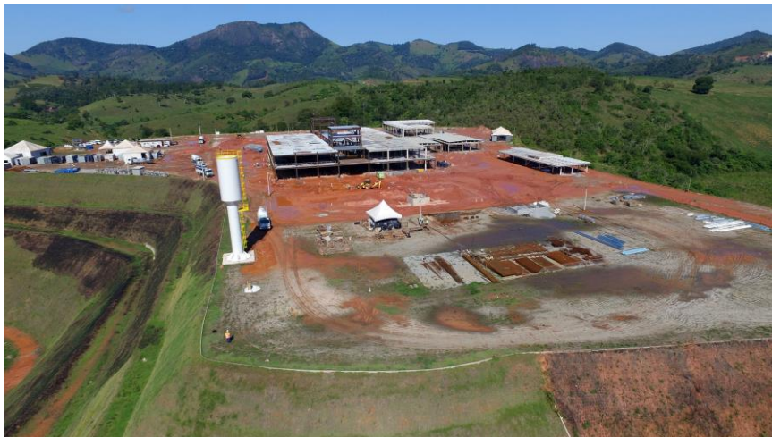
Foto área da obra
