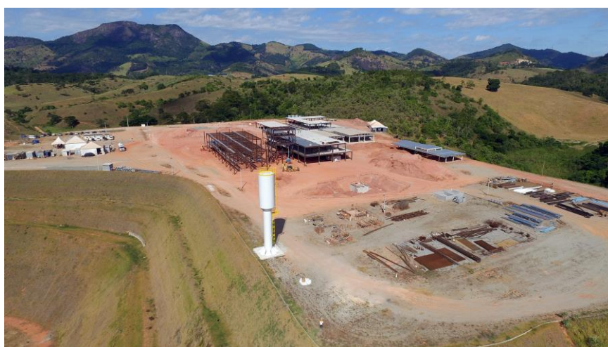
Foto área da obra
