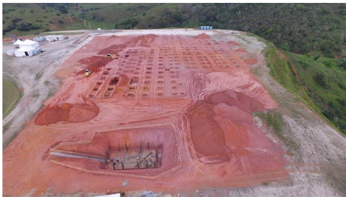
Foto aérea da construção.
