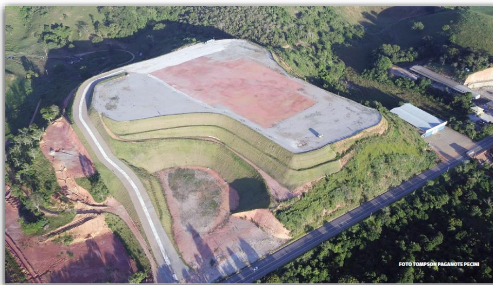
Figura 5 Terreno onde será edificado o Hospital, com 73.200 m 2 e já integralizado pela Unimed no Fundo (em processo de registro da transferência em cartório).
