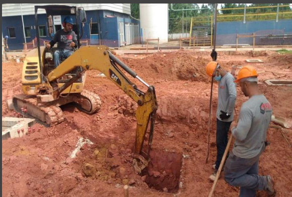
ESCAVAÇÃO MANUAL E MECANIZADA DOS NOVOS BLOCOS DE FUNDAÇÃO
