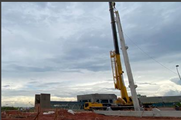
MONTAGEM DOS PILARES
