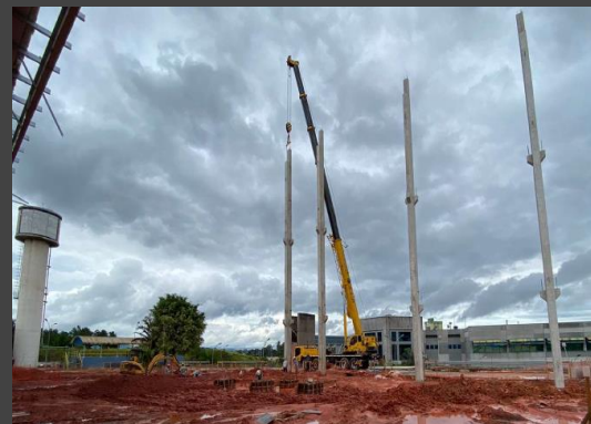
MONTAGEM DOS PILARES
