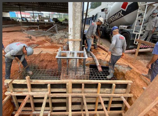
CONCRETAGEM DOS BLOCOS DE FUNDAÇÃO
