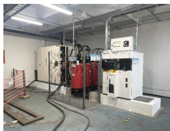
Instalação do PMT e do transformador na subestação do Galpão B
