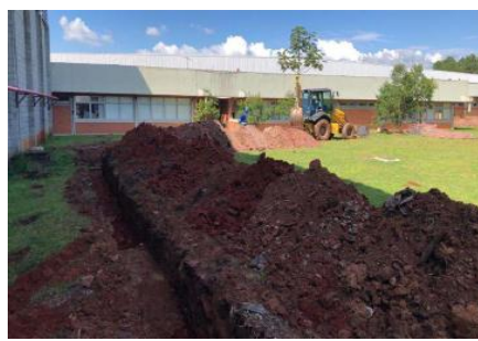
Escavação para infraestrutura da nova rede elétrica
