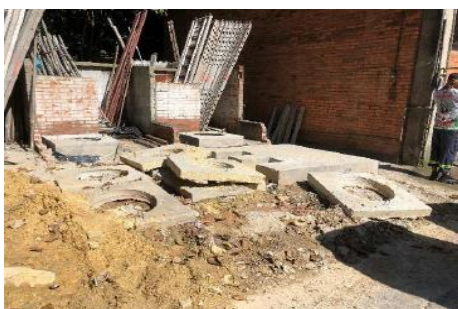
Execução de caixa de passagem e base do novo transformador
