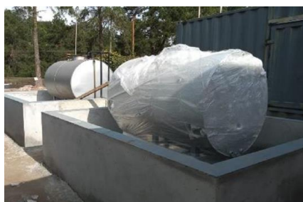
NOVAS INSTALAÇÕES DO GERADOR
