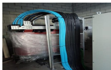
NOVA INFRAESTRUTURA DO GERADOR
