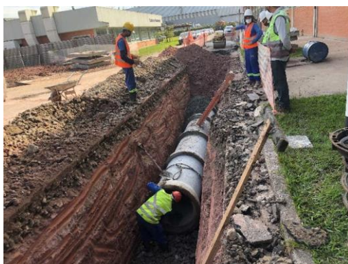
Execução da Drenagem – Área Externa
