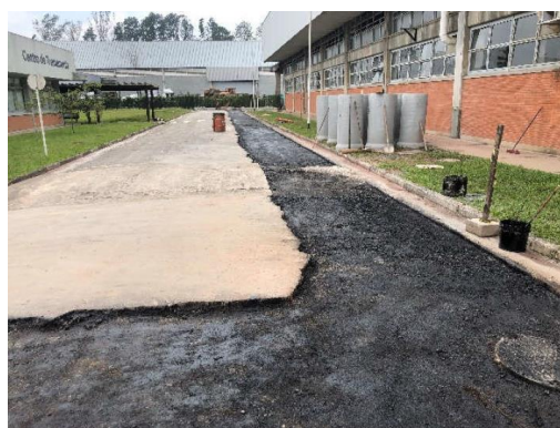
Asfaltamento parcial na área de drenagem – Galpão B Área Externa
