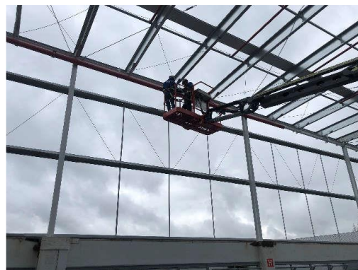
Instalação da nova rede de sprinkler
