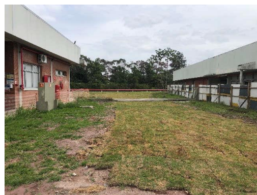
Recomposição da grama das áreas externas após a instalação da nova rede de drenagem
