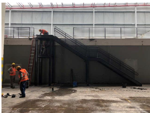
Instalação da escada e guarda-copos dos mezaninos
