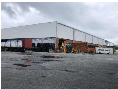
Vista Externa do Galpão B
