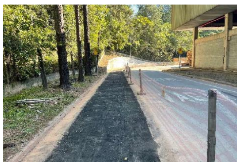
EXECUÇÃO DO NOVO ASFALTO SOB A REDE ELÉTRICA
