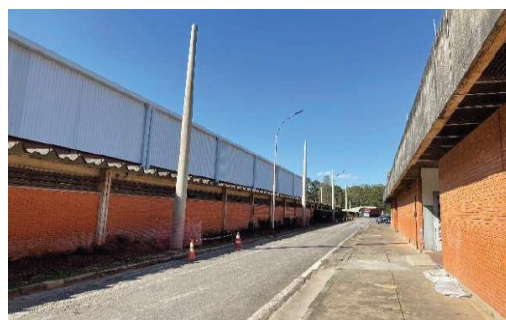
INSTALAÇÃO DOS POSTES DA NOVA REDE ELÉTRICA
