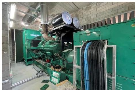
VISTA INTERNA DO NOVO GERADOR INSTALADO
