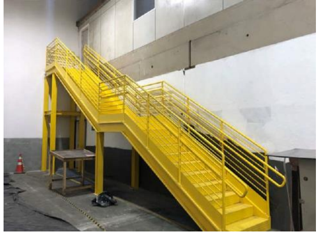
Instalação da escada metálica - 2ª fase Galpão A
