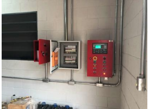
Instalação dos quadros - Casa de bombas
