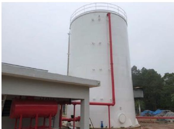
Pintura Reservatório Metálico
