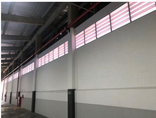
Instalação das venezianas - 2ª fase do Galpão A
