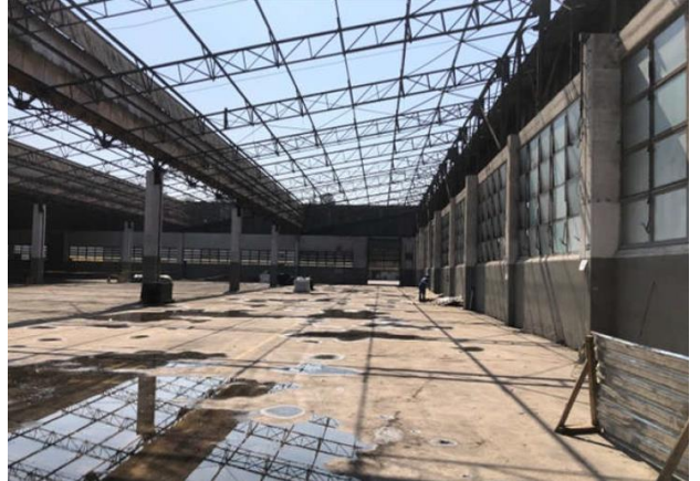
Demolição da cobertura - 1ª fase Galpão B
