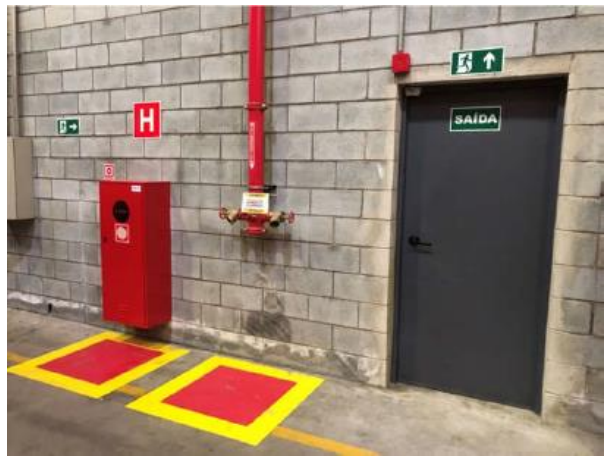
Instalação da PCF
