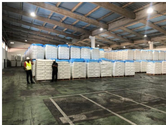
2ª fase Galpão A
