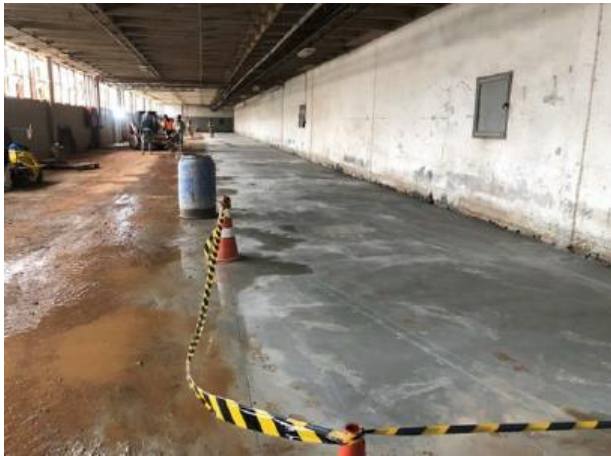
2ª fase Concretagem do piso abaixo do mezanino - Galpão B
