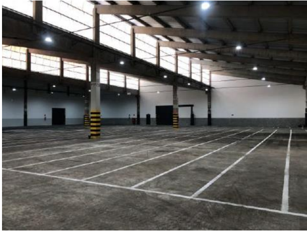
2ª fase Galpão A
