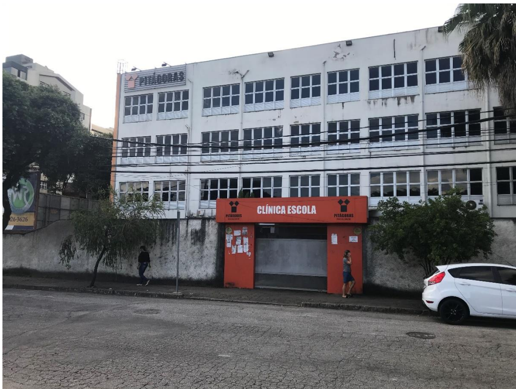
Vista da fachada secundária do imóvel
