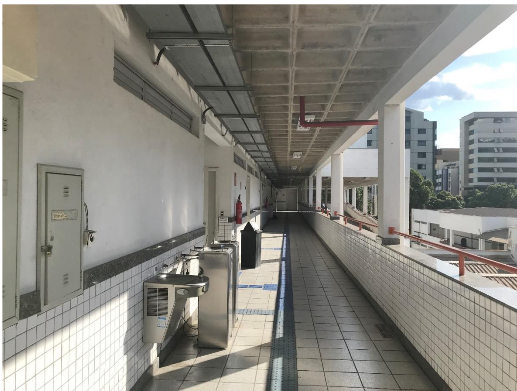
Vista interna do imóvel
