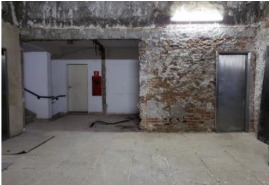
DEMOLIÇÃO - HALL DO TÉRREO
