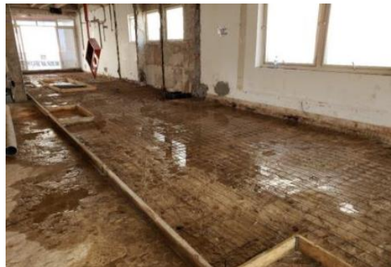
ARMADURA - NOVAS LAJES DOS CONJUNTOS
