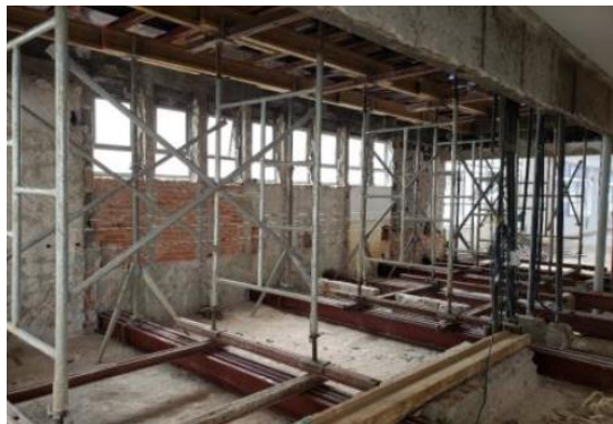
CIMBRAMENTO - NOVAS LAJES DOS ANTIGOS SANITÁRIOS
