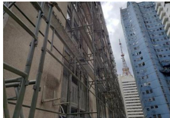
MONTAGEM DO ANDAIME FACHADEIRO
