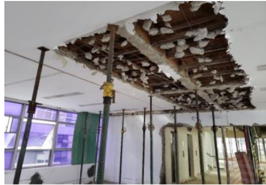
DEMOLIÇÃO - PARA INSTAÇÃO DOS PERFIS METÁLICOS
