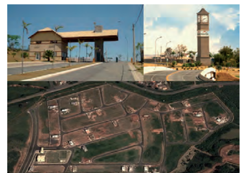
Fotos do Empreendimento – Fonte: Google
