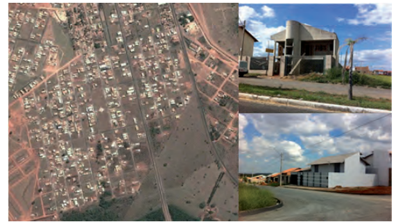
Loteamento Estrela – Fonte: Google
