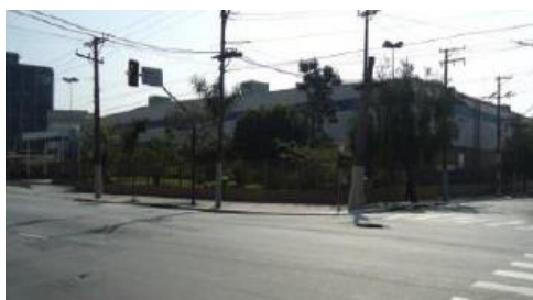
Imóvel Barra Funda – SP
